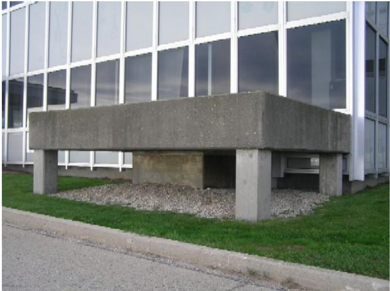
Figura 4.23 - Scudo di protezione da missili generati da tornado per la conduttura di aspirazione
